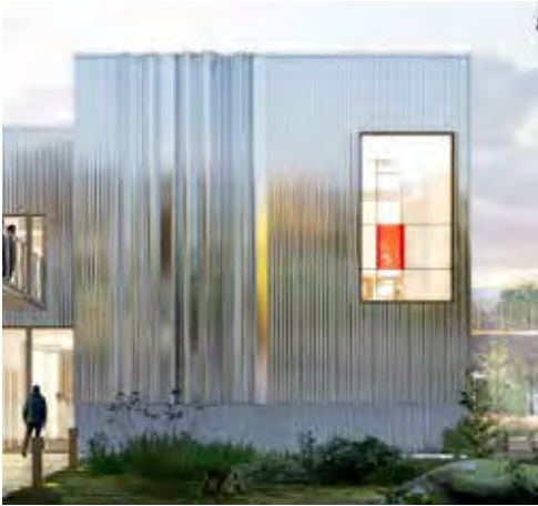
Fig.24. Bebyggelsen inden for byggefelt 4 skal stå på en base af genbrugsbeton med facader af profileret blankt metal i et varieret kurveforløb. © Loop Architects & Kragh Berglund
