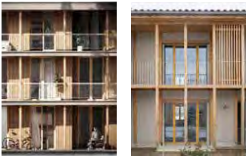
Fig.17. Fotos af altaner, der er integreret i bebyggelsens arkitektur, og som lokalplanen muliggør. Søjler og dæk skal sammen med dybe tagudhæng tydeligt definere et sekundært facadeplan, hvor indenfor altanerne skal holdes.
