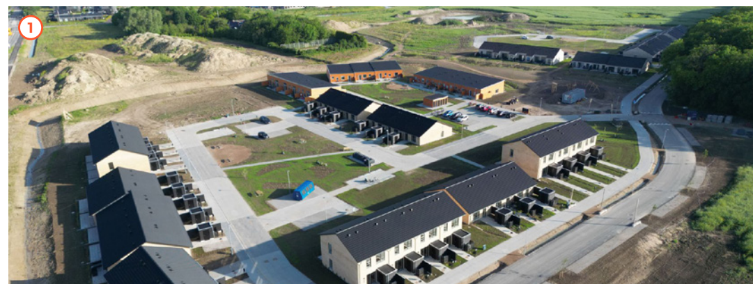
Skousbo, etape 2: 62 rækkehuse, herunder 30 almene, samt 8 parcelhuse indflyttet i 2024-25.
